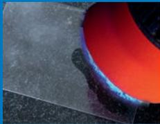
LED-Lichtgerät auf die Schadstelle setzen und härten lassen.
