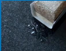
Material mit dem Hobel abtragen. Schadstelle mit verschiedenen Schleifsteinen nass überschleifen.
