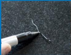
Einbringen von Transparent flüssig und mit Schutzfolie abdecken.
