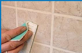
**Technologie 2:** Die Schadstelle wird gesäubert und vorbereitet. Der gehärtete Spezialfüllstoff wird erhitzt und geschmolzen, farblich angemischt, ausgehärtet und bündig abgetragen. Die Maserungen werden retuschiert, versiegelt und der Glanzgrad angepasst.
