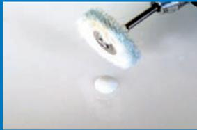
**Technologie 1:** Nach einer Reinigung, Entfettung und Vorbehandlung mittels Haftvermittler werden flüssige Spezialfüllstoffe – die vorher farblich angemischt wurden – in die Schadstelle appliziert und mit einem Spezial-LED-Lichtgerät ausgehärtet. Der Überschuss wird mit einem Hobel abgetragen, die Stelle geschliffen und aufpoliert.
