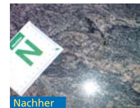
Schlagschäden an Migmatitbodenbelag
