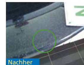
Schlagschäden an Migmatitbodenbelag
