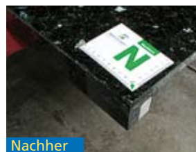
Kantenbruch Granit-Arbeitsplatte (Labrador Sea Pearl)
