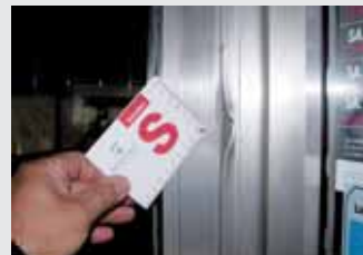
Hebelspuren Alutür
