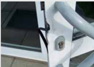
Hebelspuren Alutür
