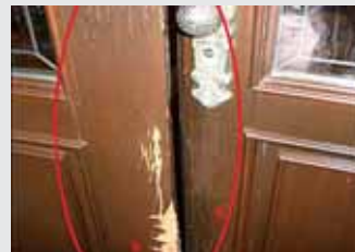
Kratzer, Kerben Holztür
