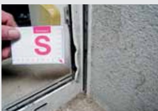
Hebelspuren Alurahmen
