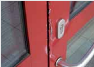
Hebelspuren Alutür
